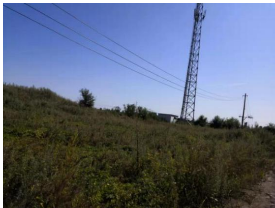
东侧侧-园区未利用地
